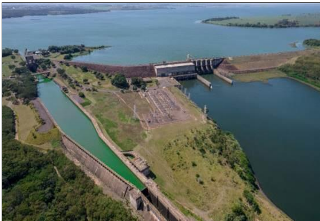
Imagem 1 - Vista geral da UHE Nova Avanhandava, Rio Tietê
