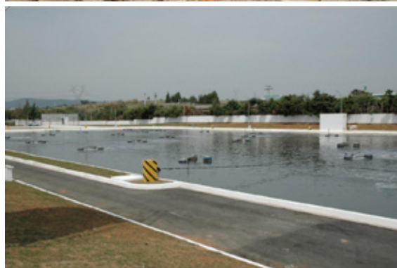
Figura 32 – Ampliação da ETE do município de Cabreúva/SP – situação antes e depois.
