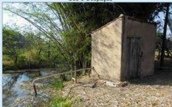
Captação de água - particular (Ago./12)
