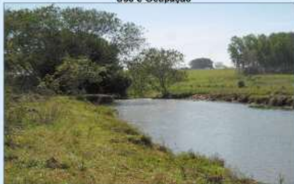
Captação de água - SAEB (Set./12)
