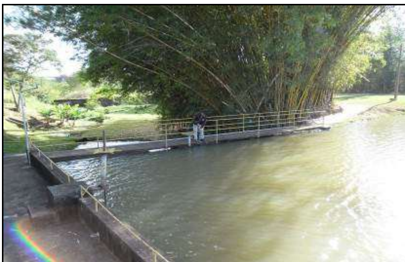
Figura 1. Aspectos parciais da captação pública de água de Guararapes. (Foto: agosto/12)
