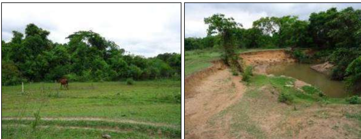
Figura 531. Vista parcial do trecho J_L. (Foto: Nov./12)
