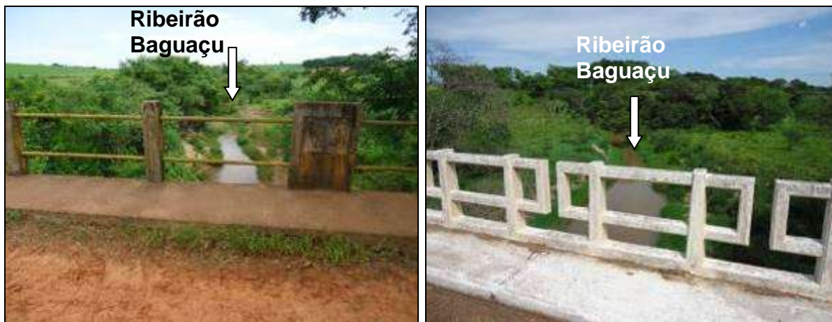
Figura 539. Vista geral da travessia de estradas rurais e vicinais sobre o Bagaçu e seus afluentes. (Foto Dez./12)
