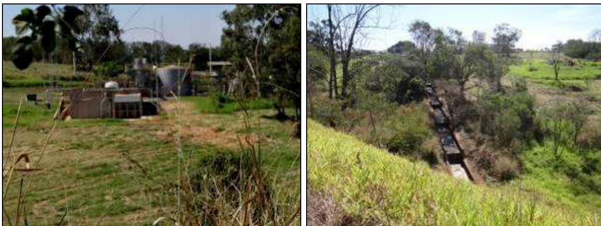
Figura 544. À esquerda, vista parcial da E.T.E e a direita vista do lançamento de efluentes no rib. Baguaçu.(Foto: Ago./13)
