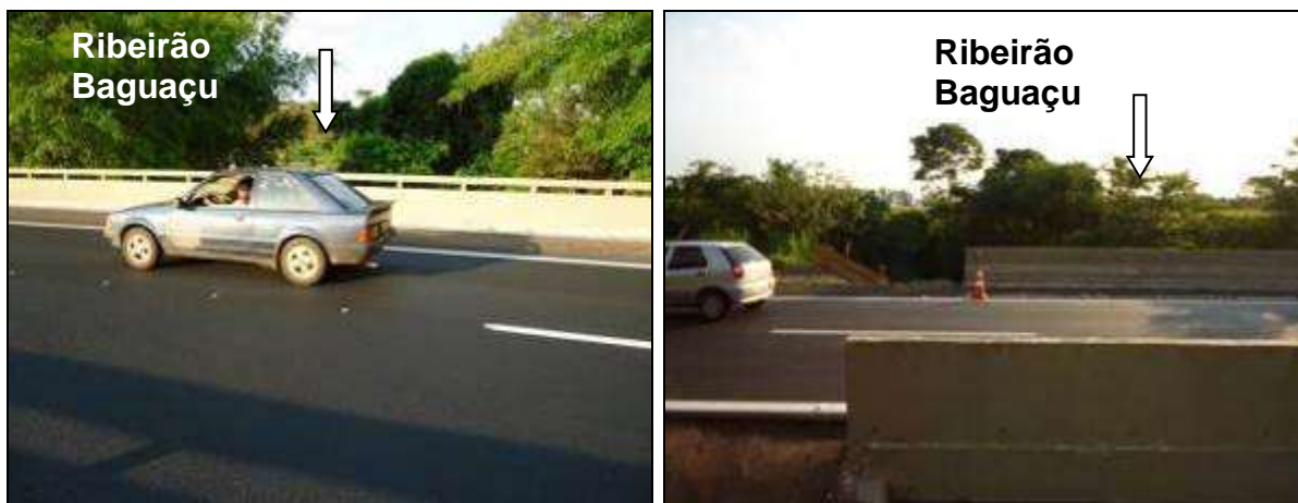
Figura 538. Vista geral da travessia da rodovia SP-300 sobre o Bagaçu. (Foto Nov./12)
