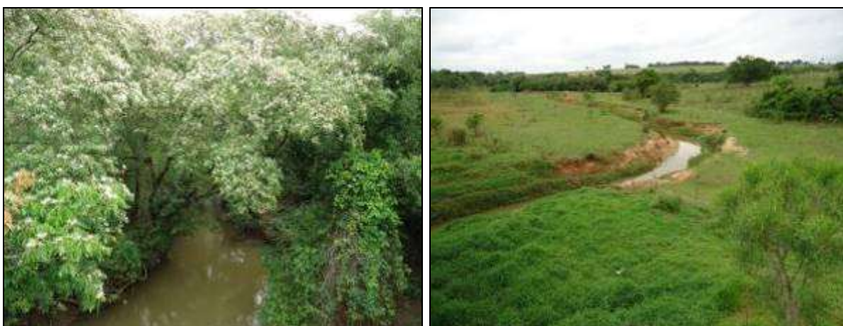
Figura 527. Vista parcial do trecho H_I. (Foto: Nov./12)
