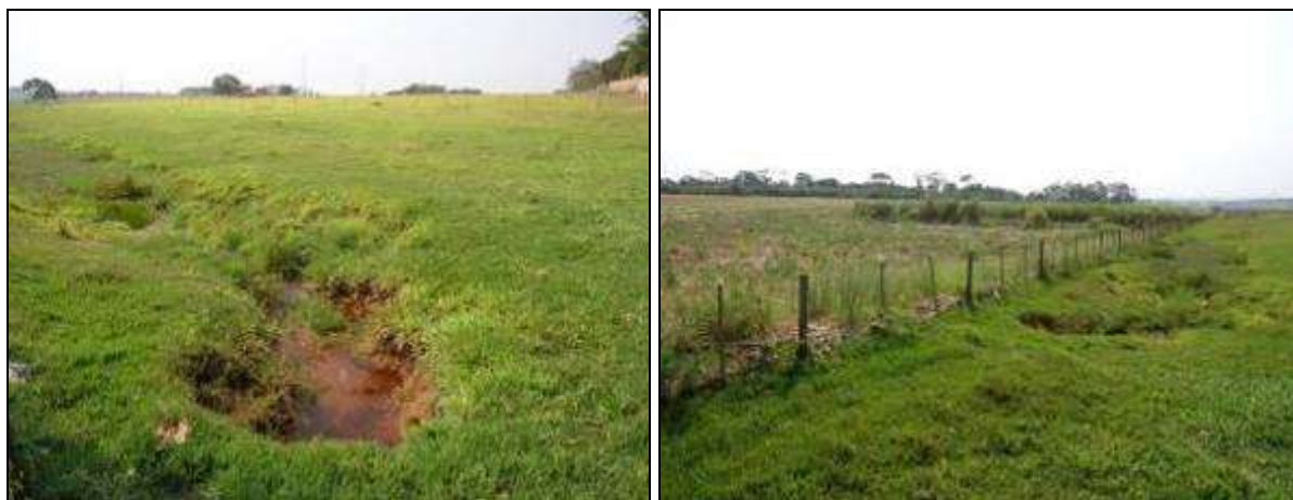
Figura 484. Vista geral de usos do entorno da nascente. (Foto: Fev./13)
