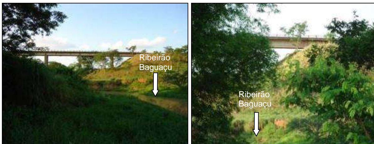
Figura 540. Travessia da estrada de ferro sobre Ribeirão Bagaçu. (Foto Nov./12)
