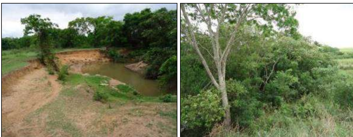
Figura 533. Vista parcial do trecho L_M. (Foto: Nov./12)
