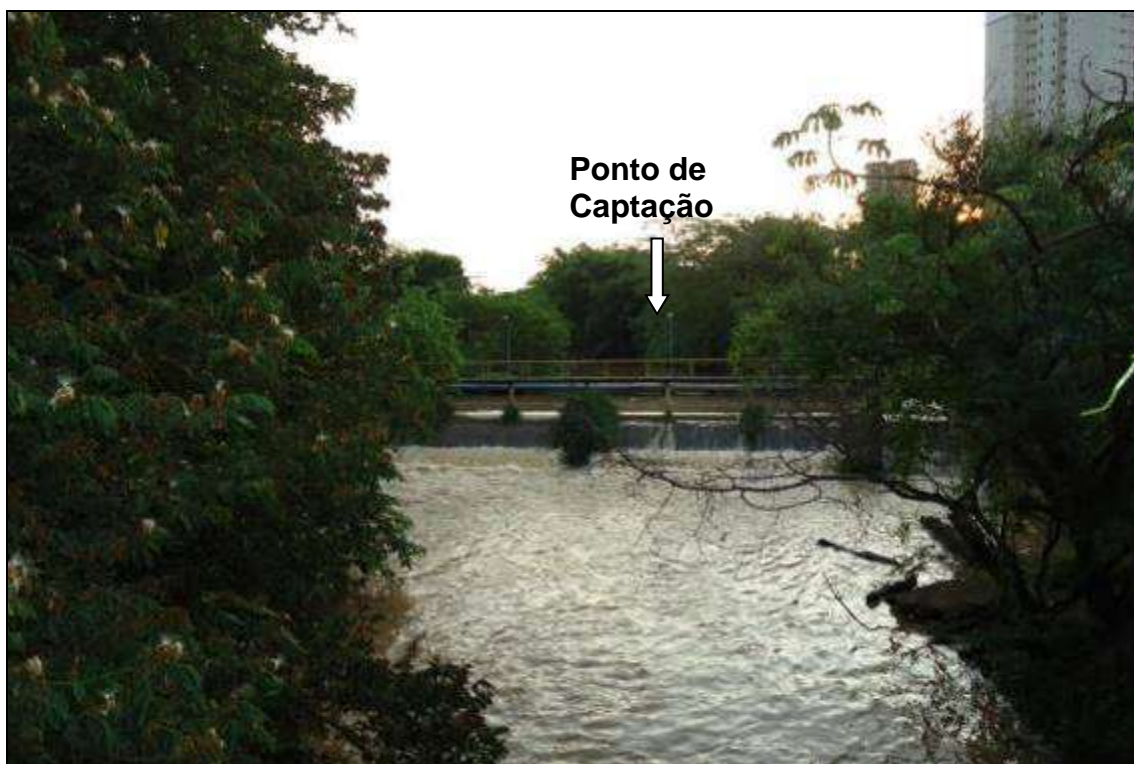
Figura 546. Aspectos parciais do ponto de captação de água para abastecimento público de Araçatuba. (Foto: Nov./12)
