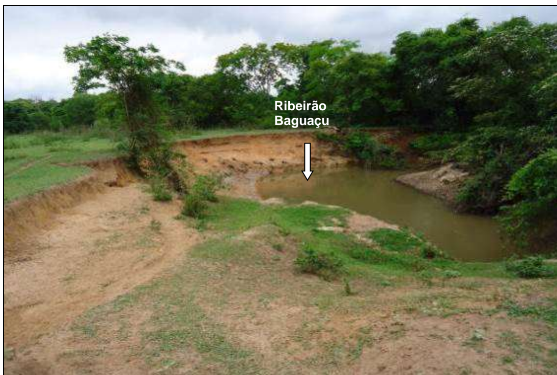
Figura 547. Processos erosivos ao longo do Ribeirão e das estradas e rodovias. (Foto: Nov./12)
