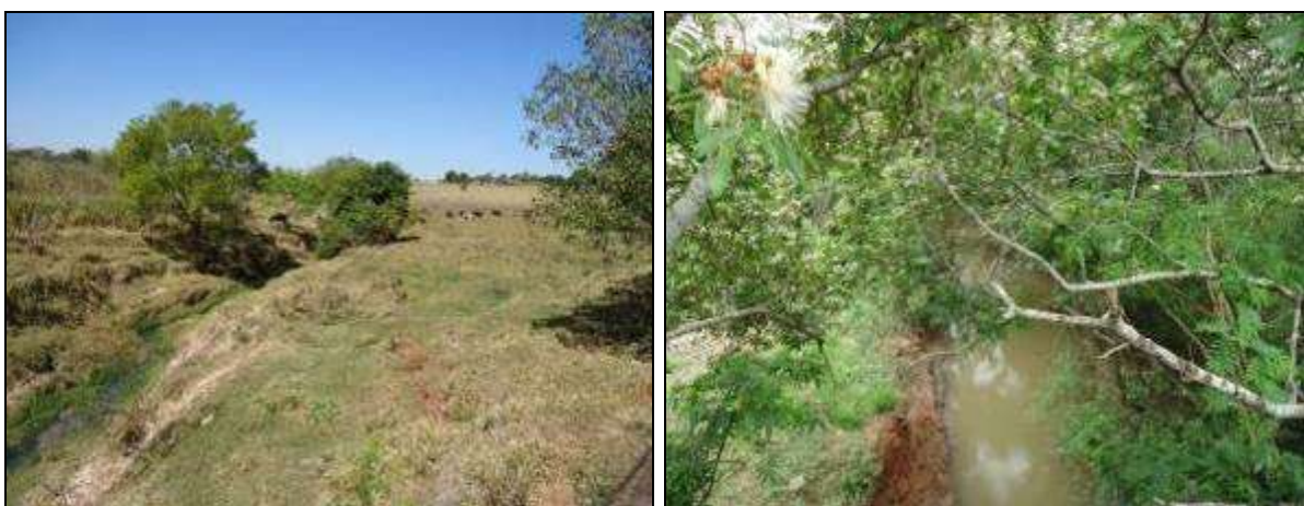
Figura 515. Vista parcial do trecho B_C. (Foto: Set./12)
