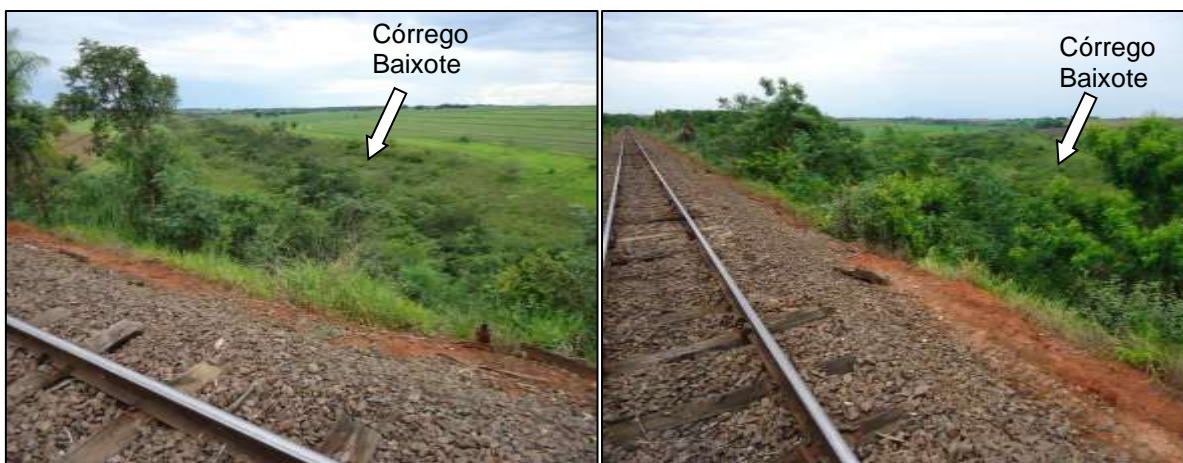
Figura 92. Travessia da estrada de ferro sobre Córrego Baixote. (Foto Dez./12)
