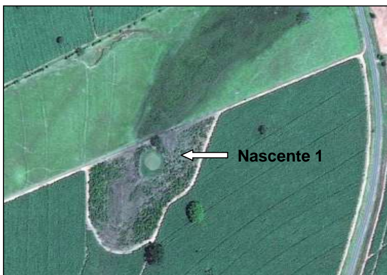
Figura 10. Vista geral da nascente 1. (Fonte: Image: 2013 © DigitalGlobe – extraída do Google Earth. Data da imagem 2011).
