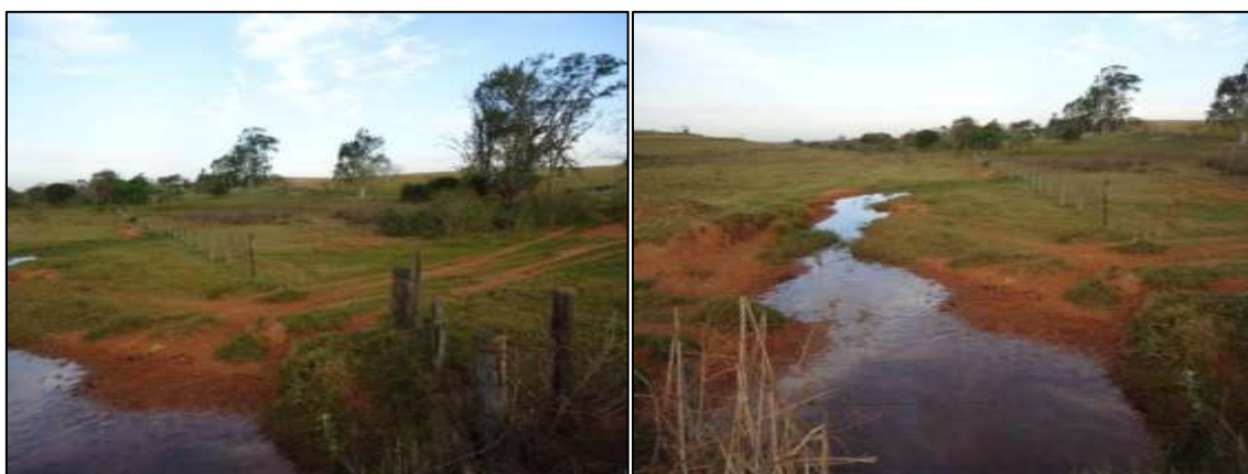
Figura 97. Processos erosivos ao longo das estradas rurais. (Foto: Nov./12)
