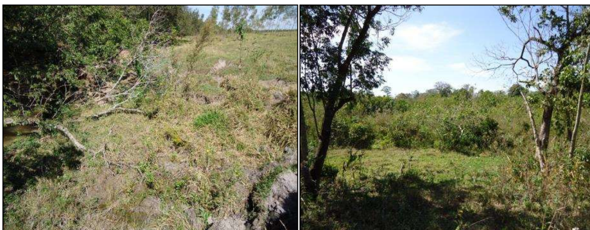
Figura 78. Vista parcial do trecho C_D. (Foto: Nov./12)
