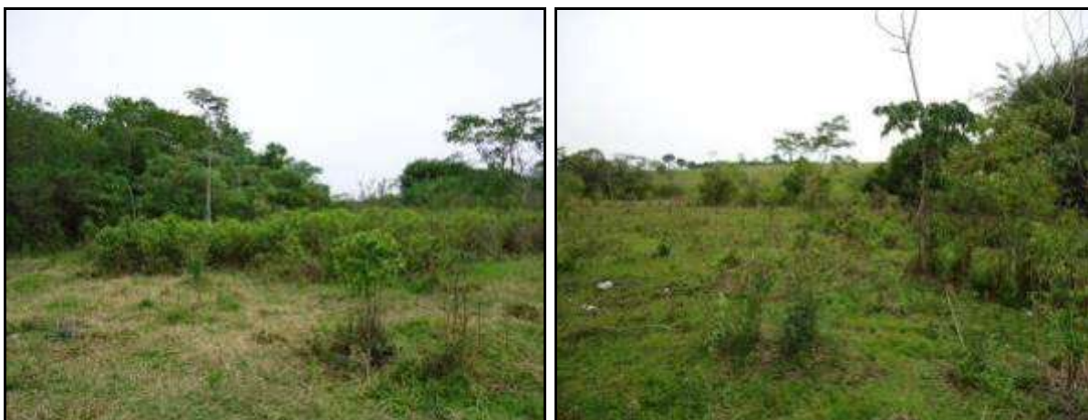
Figura 71. Vista parcial do trecho F_G. (Foto: Set.12)
