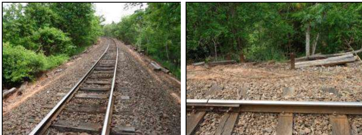
Figura 94. Passagem da estrada de ferro pelo Córrego Frutal. (Foto: Ago.12)
