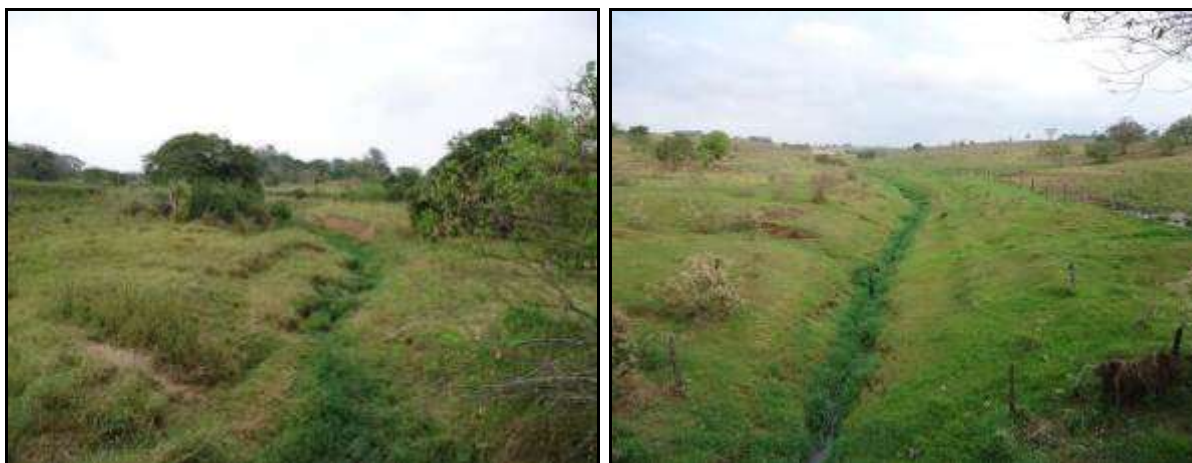
Figura 61. Vista parcial do trecho A_B. (Foto: Set. 12)
