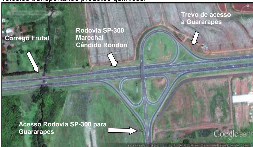
Figura 91. Localização do Córrego Frutal junto à rodovia Marechal Rondon. (Fonte: Image: 2013 © DigitalGlobe – extraída do Google Earth. Data das imagens 2011)
