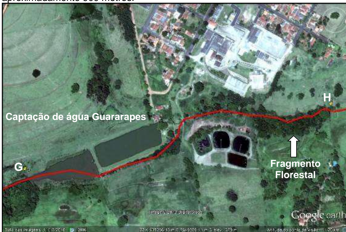
Figura 72. Vista geral do trecho G_H. (Fonte: Image: 2013 © DigitalGlobe – extraída do Google Earth. Data das imagens 2010)
