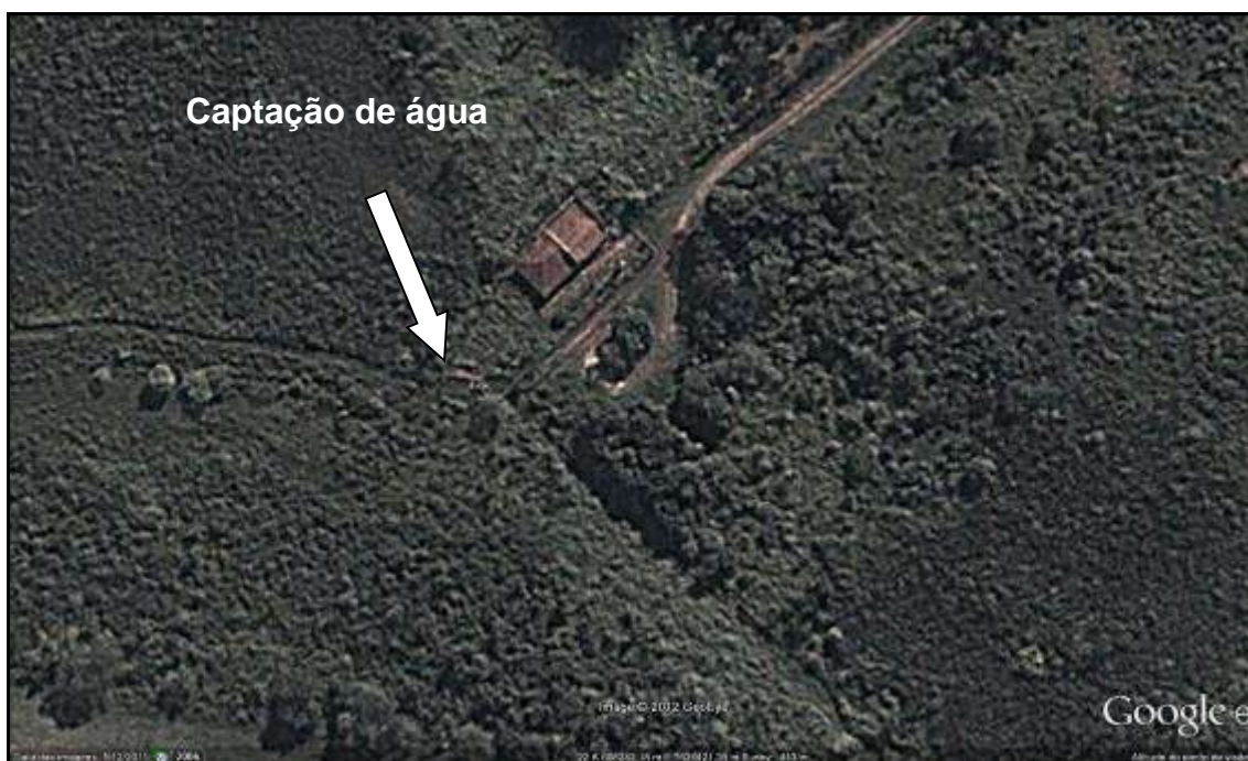
Figura 4. Vista geral do ponto de coleta Captação e dos usos no seu entorno. (Imagem: Google Earth, 2011)
