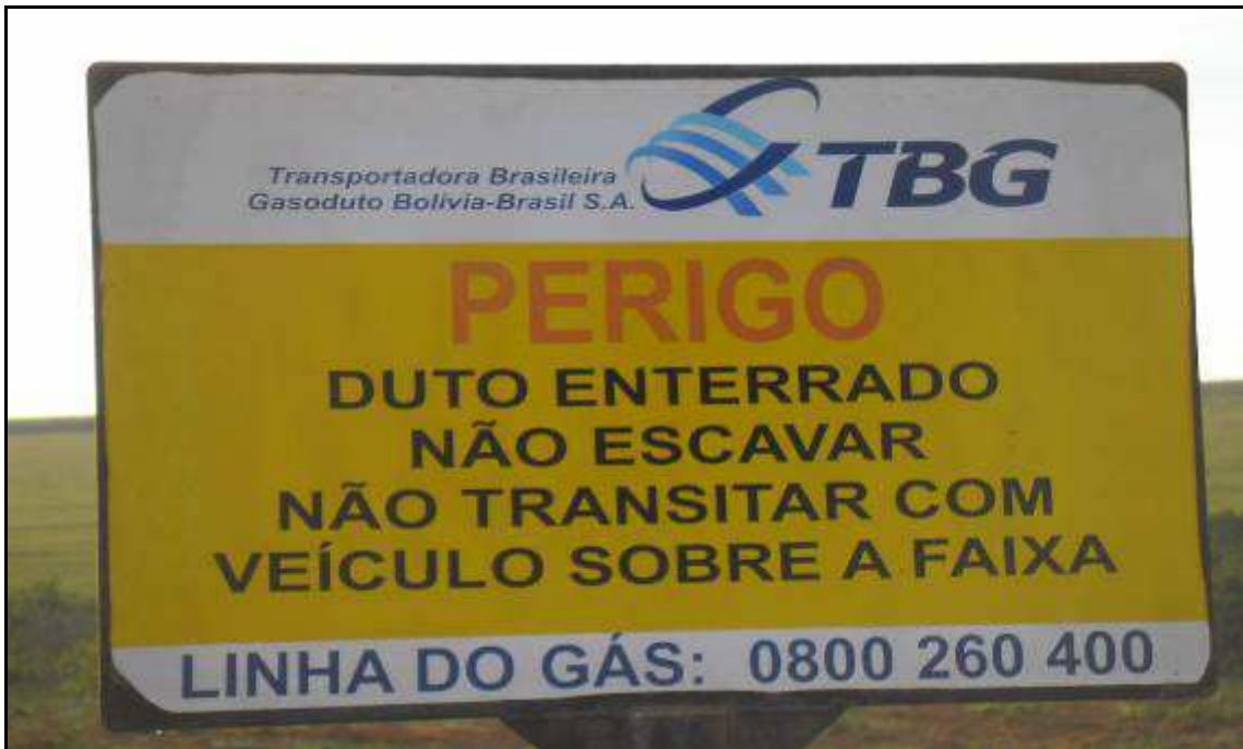
Figura 44. Placa indicativa da passagem do duto no córrego. (Foto: Ago./12)
