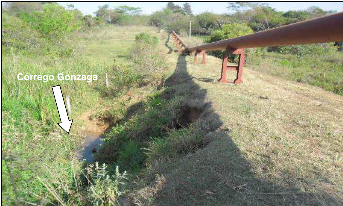
Figura 42. Vista geral do duto de transporte de vinhaça parra irrigação da cultura de cana-de-açúcar. (Foto: Ago./12)
