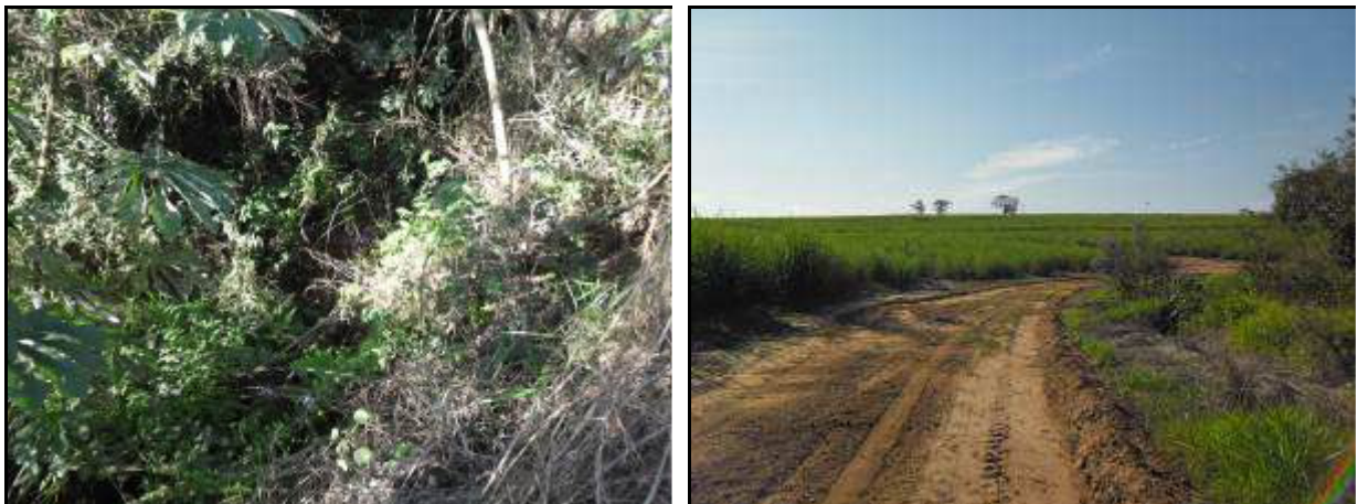
Figura 29. À esquerda início da formação da nascente e à direita estrada de serviços com início de processos erosivos no entorno da mesma. (Foto: Ago./12)
