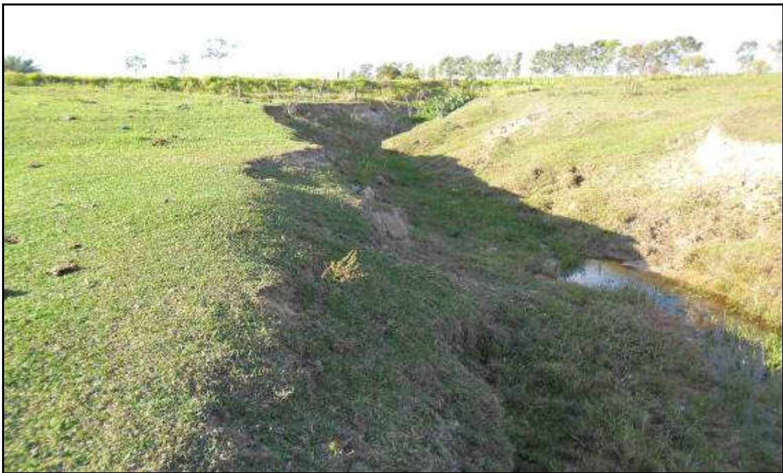
Figura 48. Voçoroca em adiantado estágio de degradação do solo. (Foto: Ago./12)
