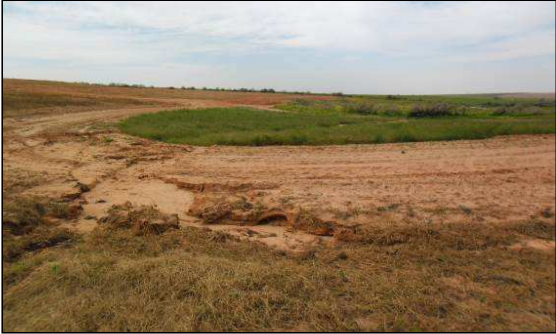
Figura 47. Processos erosivos ao longo das estradas rurais. (Foto: Ago./12)
